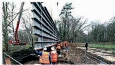
Mit Hilfe eines Krans wurde die Wand installiert.
