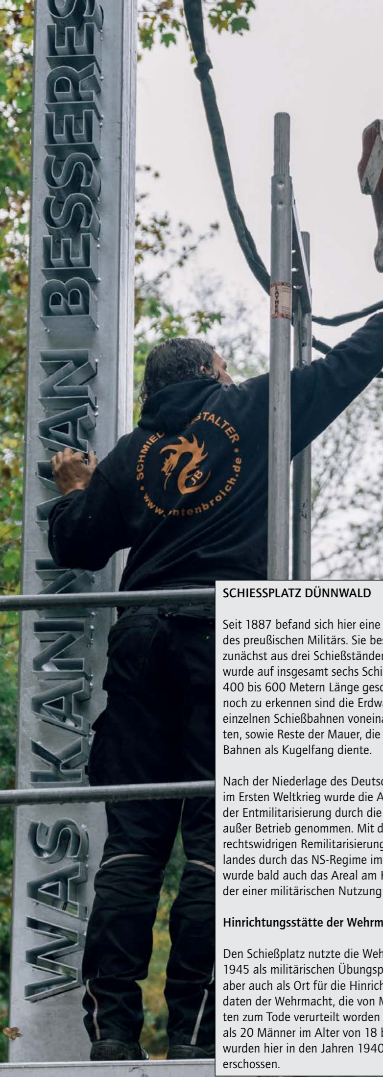
»Hochzeit«: Die Stele wird auf das Fundament montiert, 26. September 2019.
